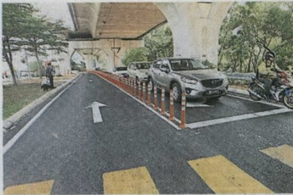
▲国家基建公司是将道路“切割”开来，保留最左边（联邦大道方向来）的一条车道，让车辆可以直驶，并将右边车道改为反方向车道。
